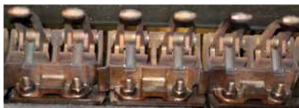
... nach der Reinigung mit ADDINOL System Cleaner HT
